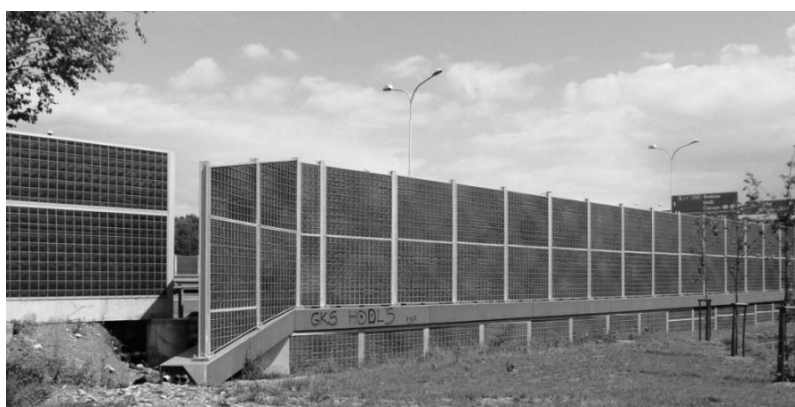
Rys. 5. Ekran akustyczny w punkcie 1, typu „zielona ściana” Fig. 5. Anti-noise screen described at point 1, “green wall” type
