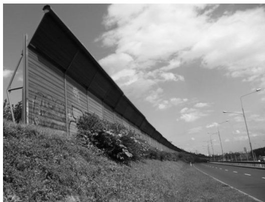
Rys. 6. Ekran akustyczny z blachy perforowanej w punkcie 2
