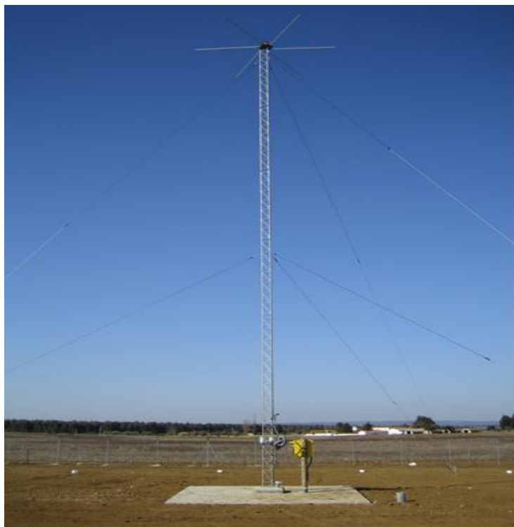
Rys. 1. Trasowa radiolatarnia NDB
