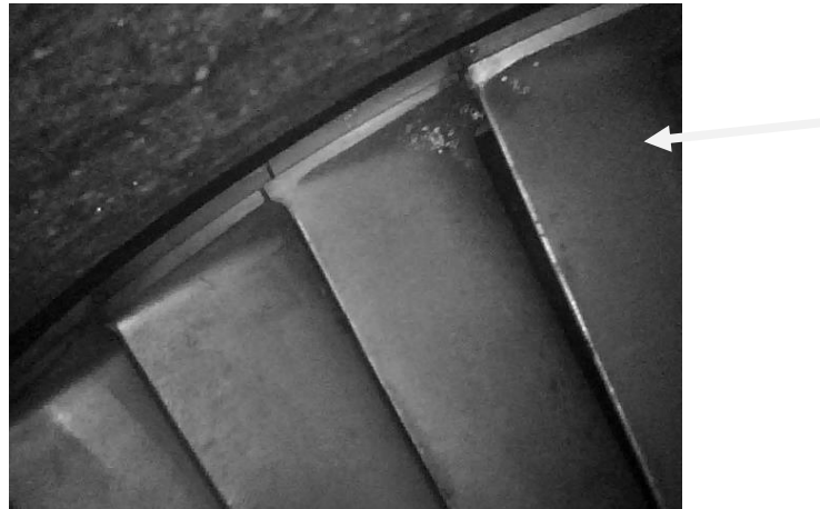
Rys. 10. Łopatki turbiny niskiego ciśnienia – zaznaczono zauważony nalot
