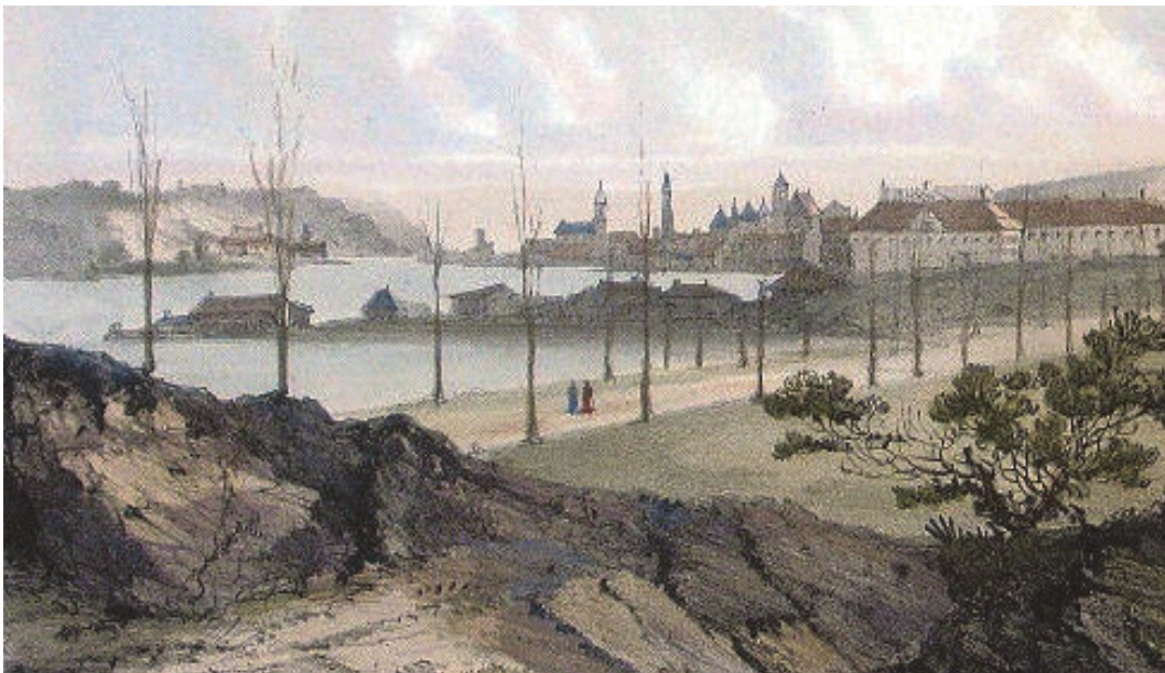
Rys. 1. Barthelemy Lauvergne, Vue de Kovno – fragment, 1840 rok (widoczny brak mostu pomiędzy Aleksotą a starym miastem w Kownie) [22]
