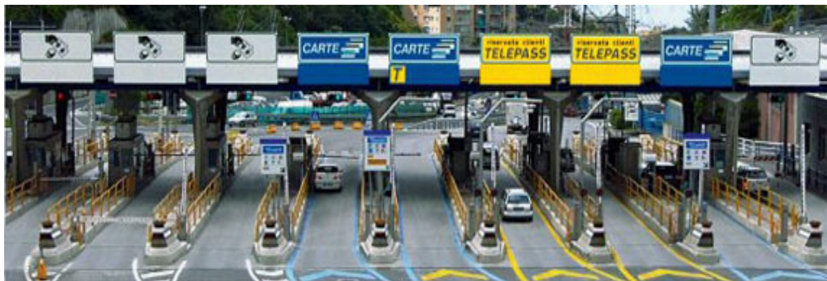
Rys. 2. Bramki wyjazdowe na włoskiej autostradzie [2]
