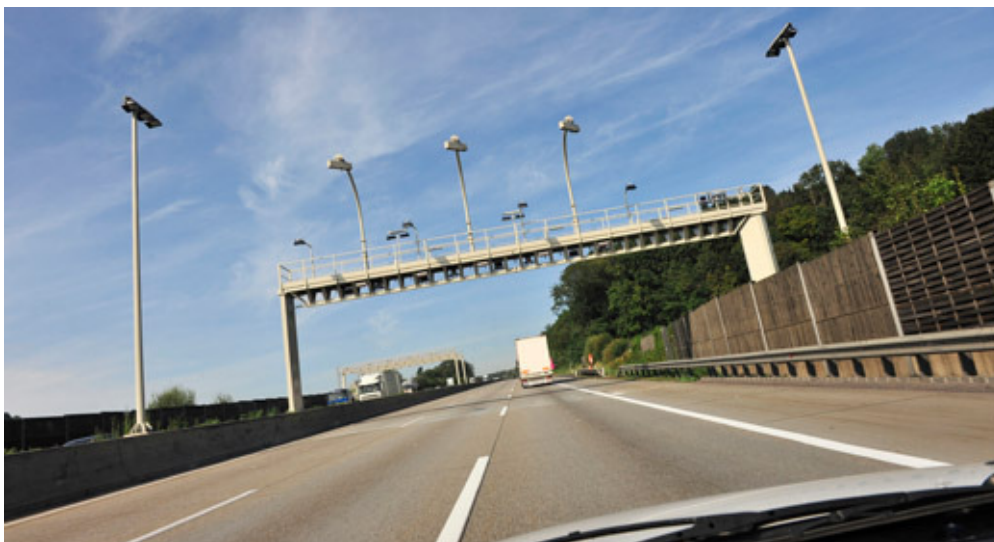
Rys. 4. Maszt wyposażony w kamery do sprawdzania uiszczenia opłaty w formie winiety [4]
