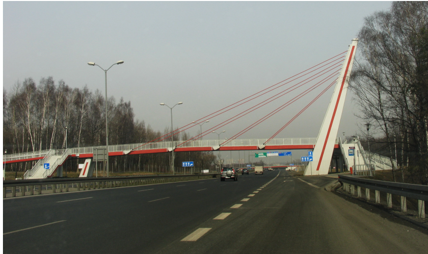
Rys. 8. Bezkolizyjne przejście dla pieszych
